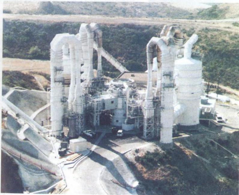
**Prikaz postrojenja gdje se vrši ispitivanje kemijskog lasera Alpha, lasera s vodik-fluoridom koji ostvaruje snagu od 2 MW, u uvjetima koji vladaju u svemiru. Ovaj laser bit će izbačen u orbitu oko Zemlje jer se njegovo zračenje ne može transportirati kroz atmosferu zbog nepovoljne valne duljine (2.7 um)**
