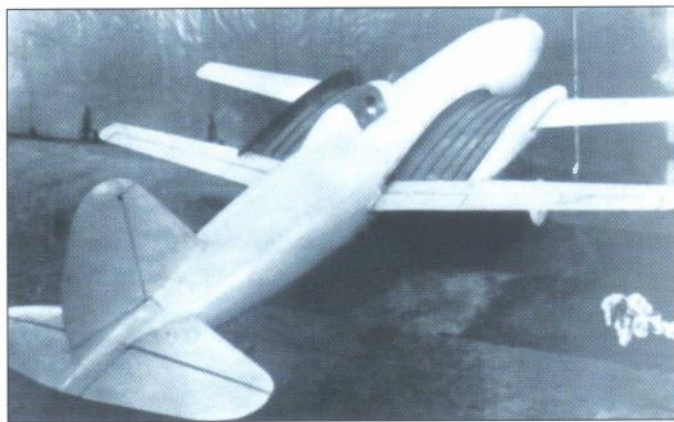
Prvi koraci koji su doveli do krila promjenjivog kuta nagiba (SW) poduzeti su prije tridesetih u Francuskoj i bivšem SSSR-u. To su bili koncepti teleskopskog i sklapajućeg krila. Lijevo je eksperimentalni zrakoplov RK-1sa teleskopskim krilima
