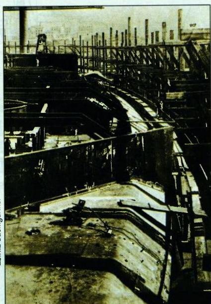
Na navozu brodogradilišta STT u Trstu snimljena je tadašnja novogradnja *Schlachtschiff IV*, budući SMS *Viribus Unitis*, na koji se postavlja oklopna paluba
