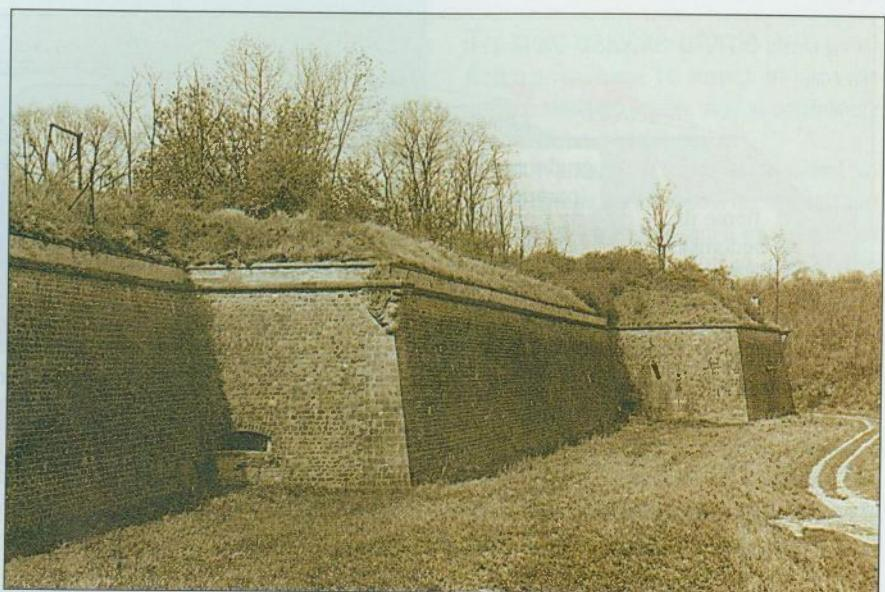
Fotografija zidova utvrde Neuf-Brisach snimljena iz rova. Krajne desno nalazi se bastionska kula. Vidljiva je toparnica (sagrađena polovicom 18. st.) u udubljenom zidu između dvije bastionske kule
