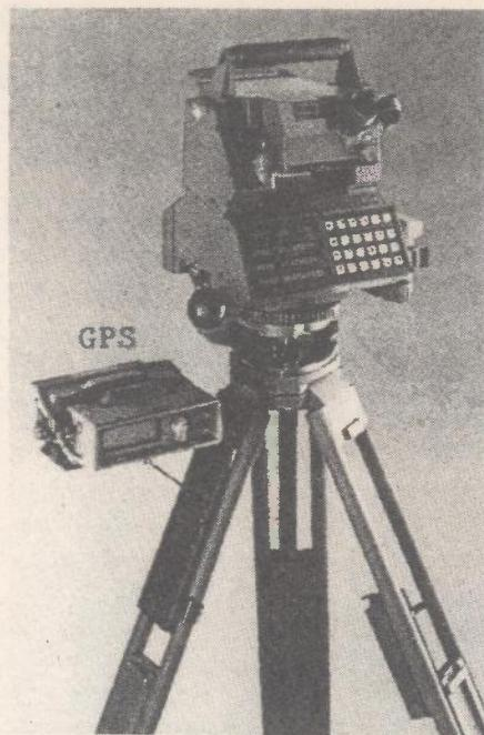
*Slika 3. Teodolit tvrtke Wild (Leica) služi za određivanje položaja topničkih ciljeva. Opremljen je laserskim daljinomjerom, giroskopom, a može se (po želji kupca) opremiti GPS prijamnikom. Kao posebna oprema uz njega se nude i pojačivači noćnog svjetla raznih vrsta (Night Vision).*
