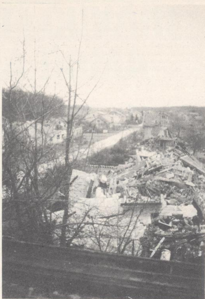
Karlovačko predgrađe teško je stradalo
