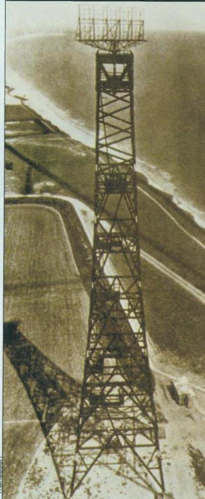
**Ključni element britanske pobede u Ijtu 1940. bio je postojanje dvije radarske mreže - Chain Home (na slici je golema radarska antena postaje mreže CH) i Chain Home Low (CHL) - koje su omogućavale pravodobno uzbunjivanje RAF-a na približavanje formacija Luftwaffe**
