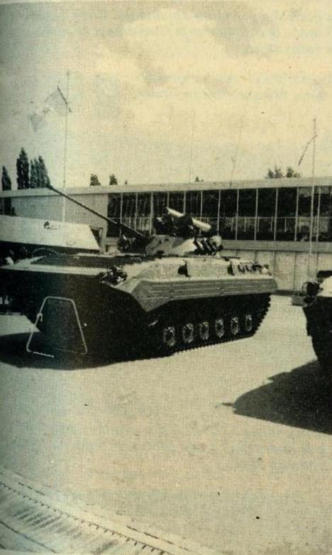
*Borbena vozilo pješastva BVP-2 (proizvođač je ZTS iz Slovačke Republike) opremljeno je topom kalibra 30 mm, protuoklopnim vodenim raketnim sustavom, te strojnicom 7,62 mm PKT. Ukupna masa vozila iznosi 14 tona*
