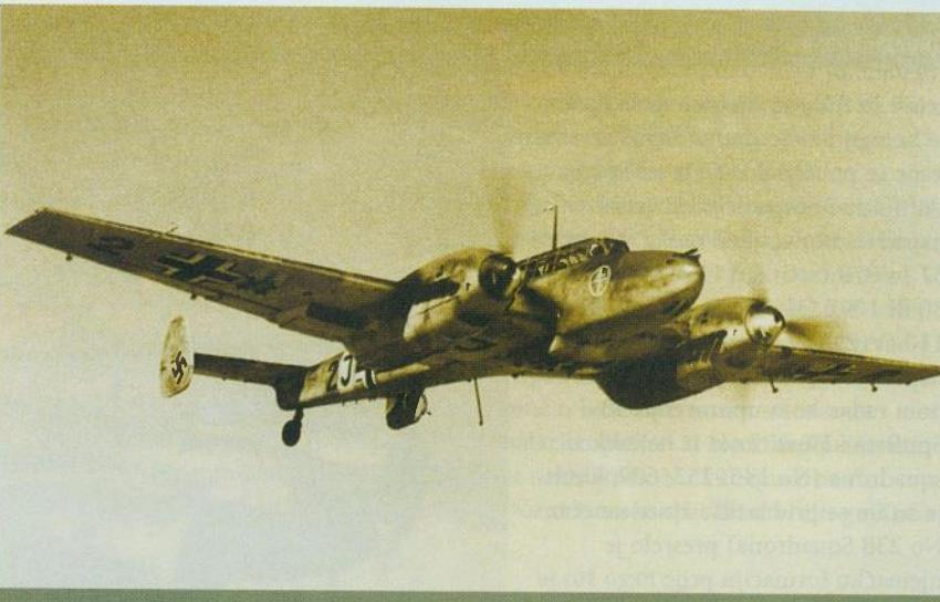
Njemački teški dvomotorni lovac Messerschmitt Bf 110C; unatoč borbenom doletu od 340 km (dovoljnom za pratinju bombardera), Bf 110 pokazao se neadekvatnim u ulozi eskortnog lovca zbog nedovoljne pokretljivosti u bliskoj zračnoj borbi
