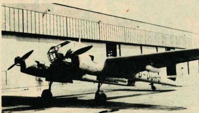
Fw 189V-4 opremljen uređajem za stvaranje dima i kemijsko ratovanje Rauchbehälter S 125 na nosaćima bombi ispod krila. Vidljiv je prvotni oblik podvozja i bočni usisnici zraka na pokrovu motora
