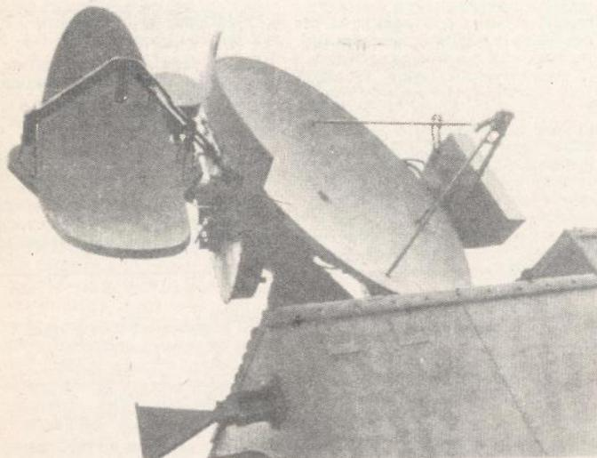
**Antenski sustav radara za osvijetljavanje cilja tipa 86**
