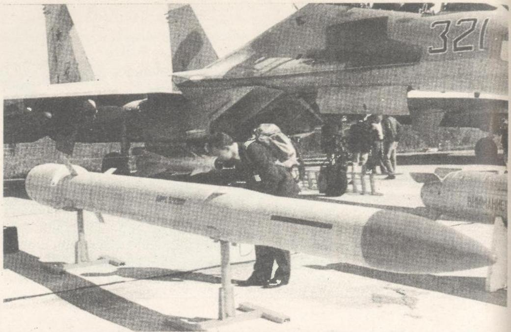
Od 1991. u Rusiji je u tijeku razvoj dalekodometnog projektila zrak—zrak Ks-172 Novator, koji će težiti 750 kg i imati domet od oko 400 km (na slici je model izložen 1993. godine)
