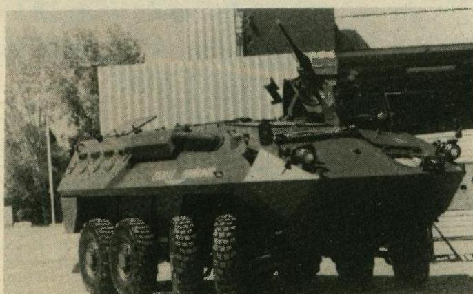
*Prototip oklopног transportera FAMAE Piranha 8 x 8D opremljen kupolom domaće proizvodnje i naoružan strojnicom 12,7 mm*
