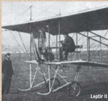
velikog polumjera nove elise ispred kotača su postavljene zaštitne skije. Ugrađena su krilca i upravljač, okomita repna stabilizirajuća površina, repna drljača umjesto repnog kotača, tandem klupica umjesto dvaju sjedala itd. Izmjene na zrakoplovu bile su značajne pa konačnu varijantu neki izvori smatraju novim zrakoplovom, a spominju ga pod nazivom Leptir 2.
