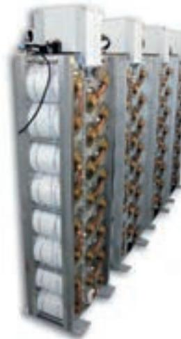
Litij-ionski modul satoji se od 23 Ćelije, a kompletna baterija od osam ovakvih modula.
