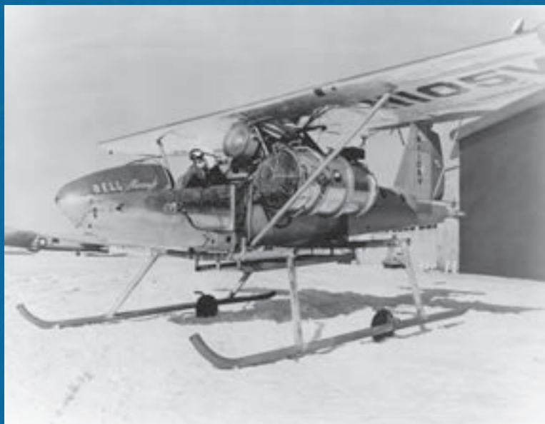
Bello Model 65 Air Test Vehicle - prvi američki VTOL avion
