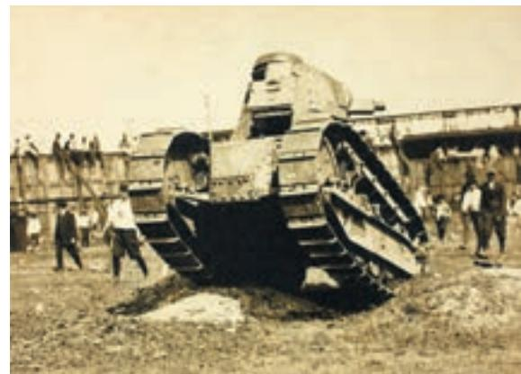
**Francuski Renault FT-17 prvi je pravi tenk, s upravljačkim dijelom, borbenim te motornim odjeljkom**
