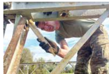
Detalj završnih radova na konstrukciji mosta
